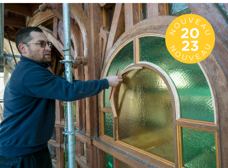
Chantier de la Buvette Cachat © Ville d'Évian (La Nouvelle image)
