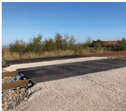
STRAIL présente innoSTRAIL, sa plateforme d'enraillement personnalisable et compatible avec tous les armements de voie.
