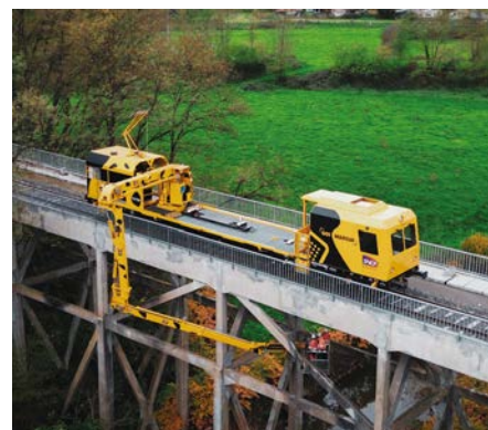
NOVIUM propose de découvrir le MARSUP, une solution unique pour l'inspection des infrastructures ferroviaires.
