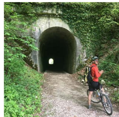
Sur le parcours, un tunnel bénéficiera d'ici fin 2022 d'un éclairage adapté.
